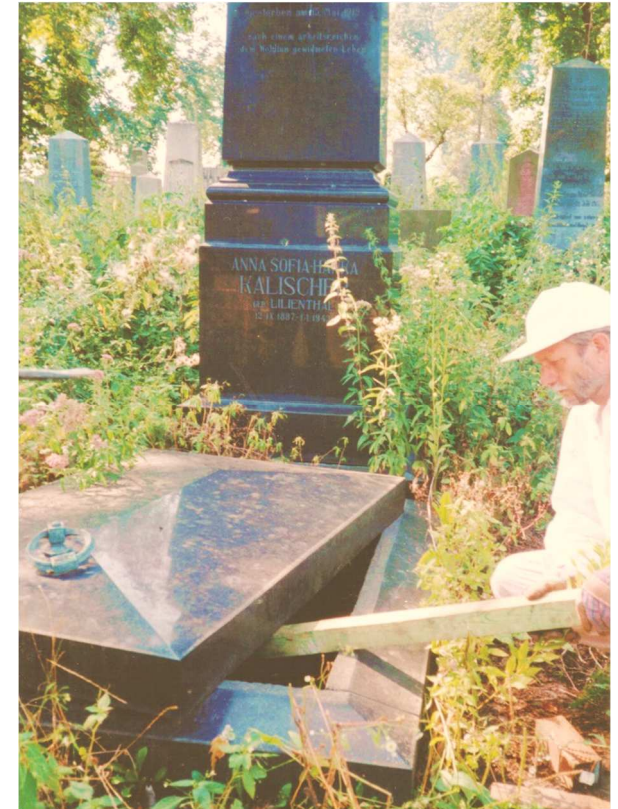
Een verschoven deksteen wordt weer teruggeplaatst
